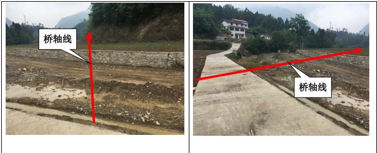
图2.3-1 K103+573 响水河中桥桥址状况
