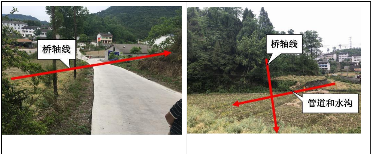
图2.3-3 K104+362.0 车坝中桥桥址状况
