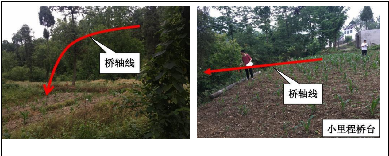
图2.3-2 K104+063.0 西北乡大桥桥址状况
