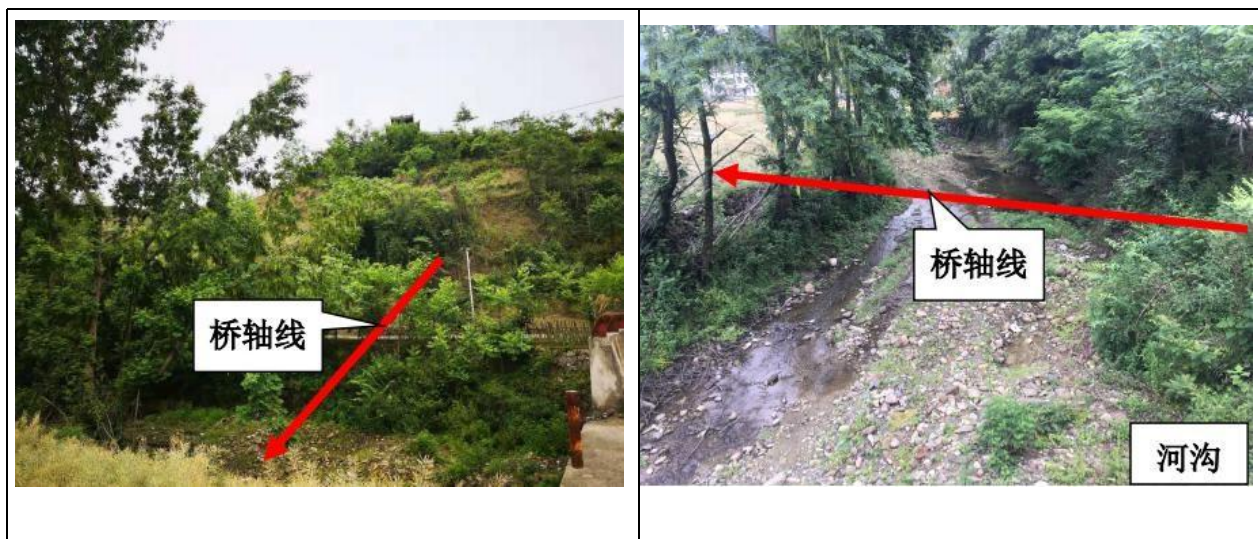
图2.3-4 K104+493.5 大田坝中桥桥址状况
