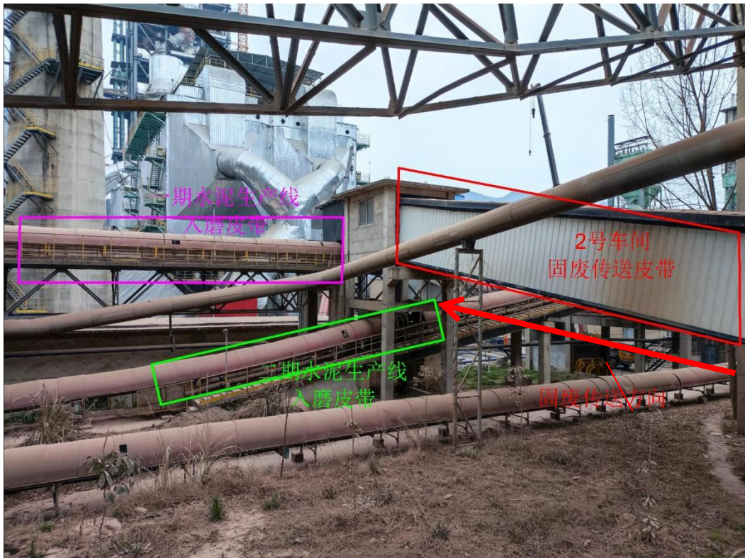
图 2-5 2 号车间固废传送皮带与水泥生产线入磨皮带位置关系
