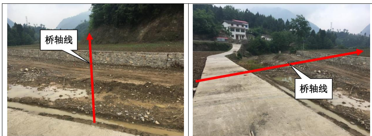
图2-3 K103+570 响水河中桥桥址状况
