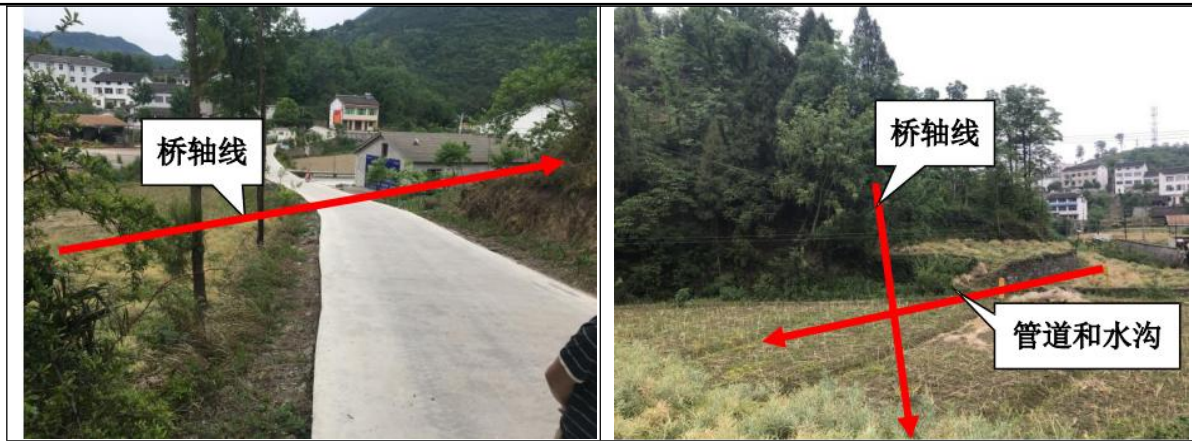
图2-5 K104+358.665 车坝中桥桥址状况
