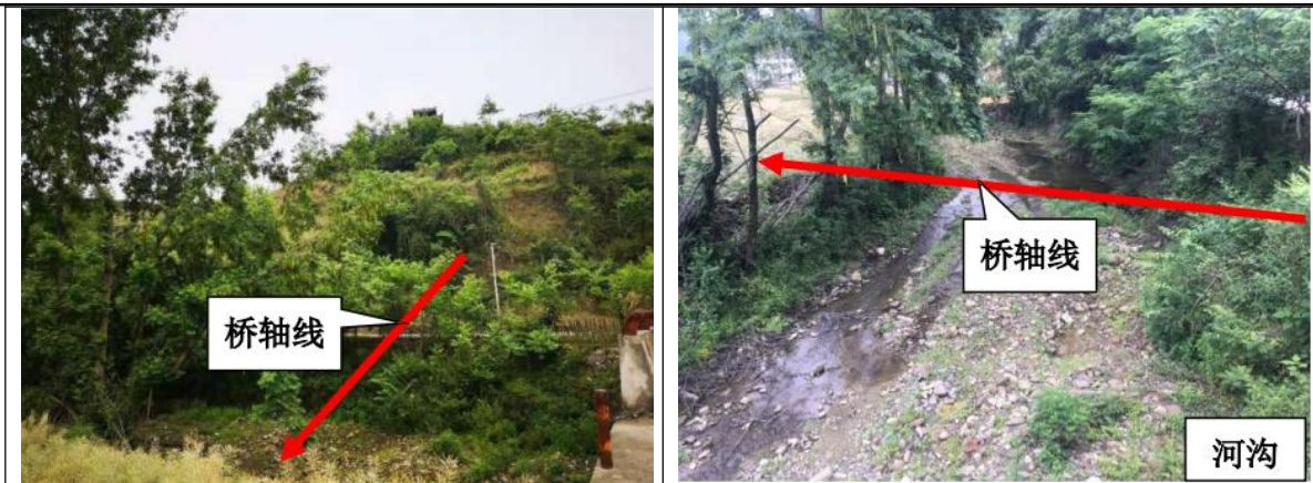
图 2-6 K104+538.3 大田坝中桥桥址状况
