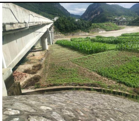
排水设施现场照片(2)
