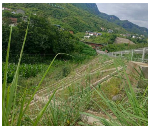
植草框格护坡现场照片(1)
