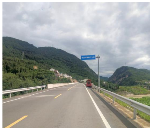
大桥现状现场照片（4）
