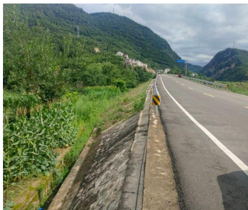
排水设施现场照片（3）
