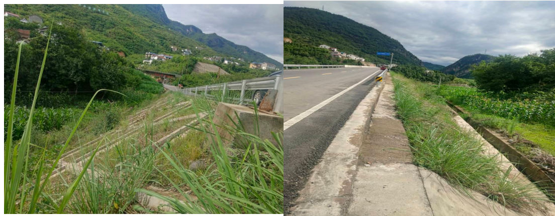
植物措施现场照片（1）
