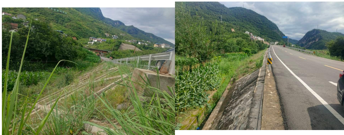
护坡工程现场照片（3）
