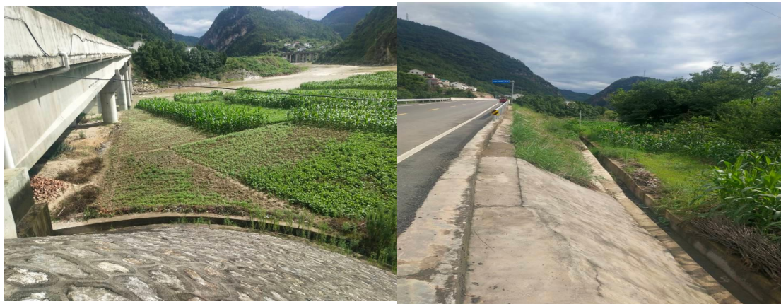
护坡工程现场照片（1）
