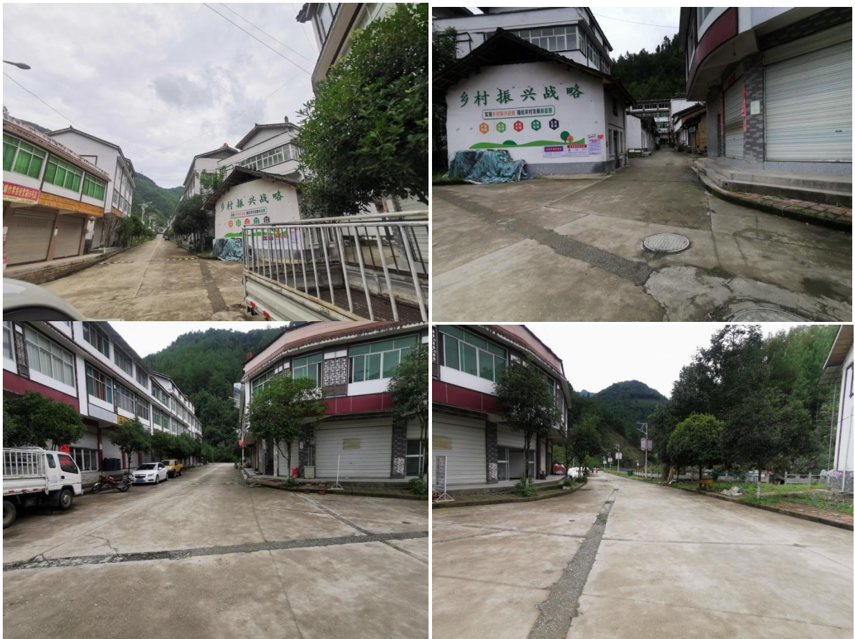
沿场镇道路铺设
