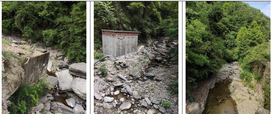
柏杨沟干流部分河段现状
