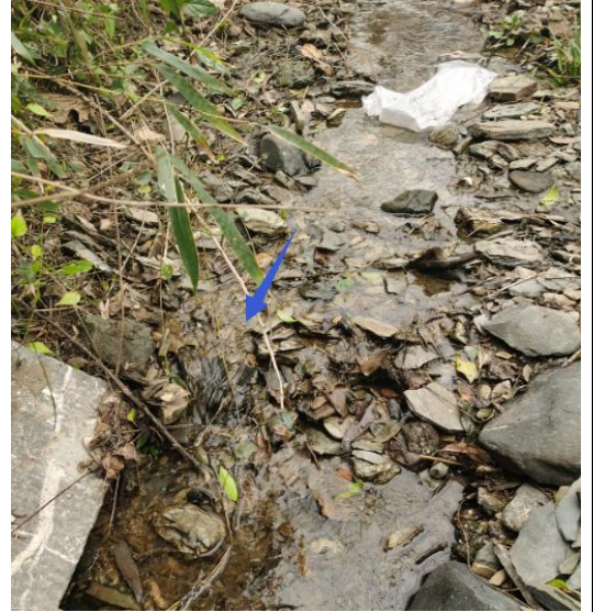
副坝位置长汉沟 2021 年 12 月现场照片
