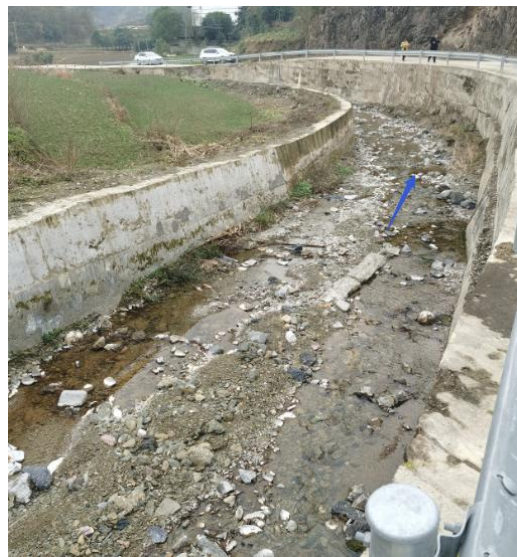
主坝位置瓦字四沟 2021 年 12 月现场照片
