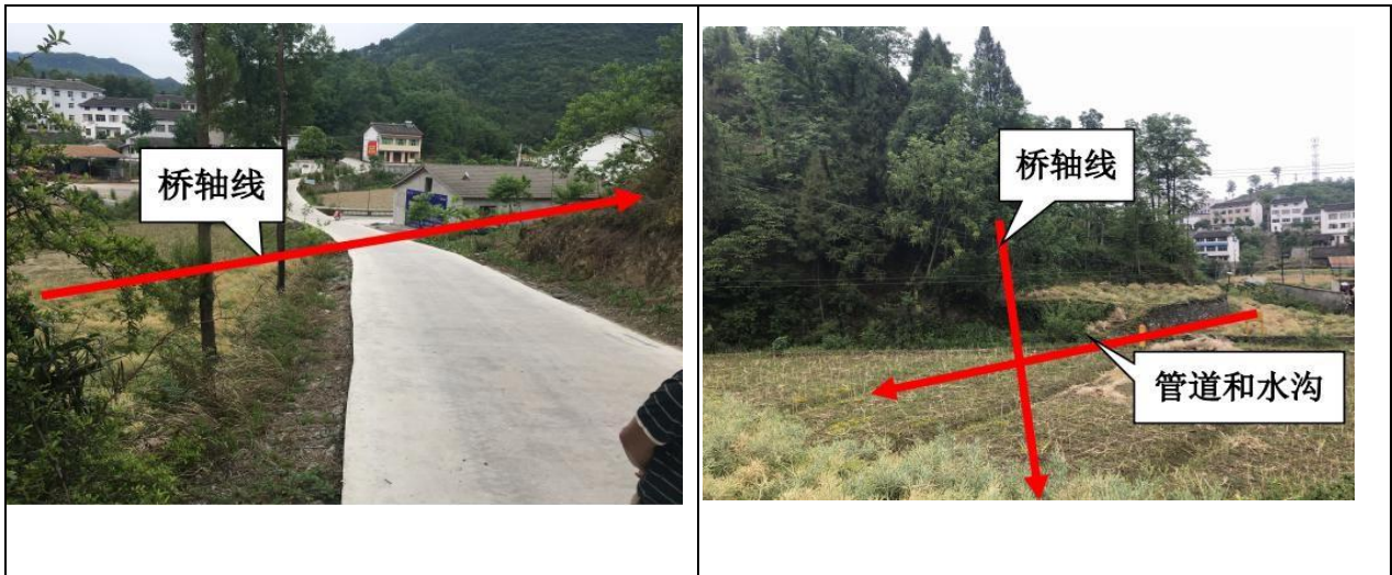
图2.3-3 K104+362.0 车坝中桥桥址状况
