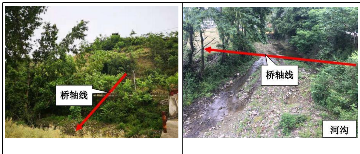
图2.3-4 K104+493.5 大田坝中桥桥址状况
