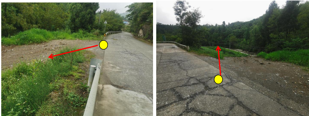
道路起点（接既有县道）
