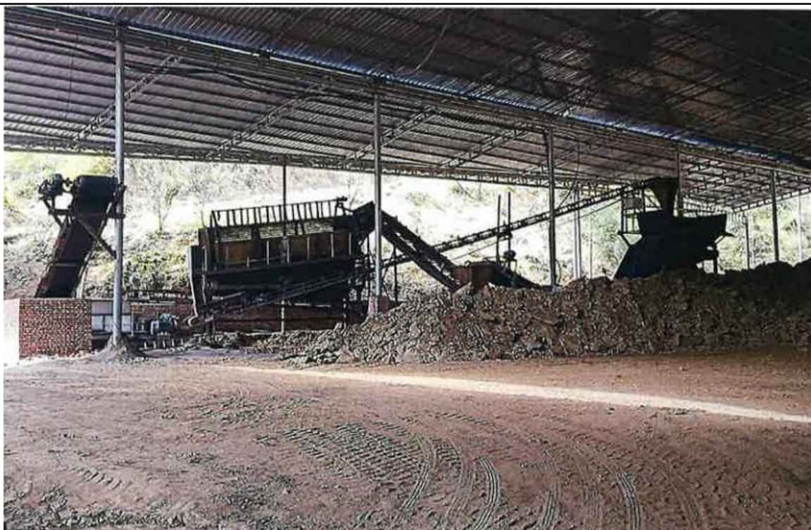
图 3-5 工业广场现状照片
